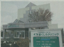
無料のPCR検査を受け付けている新しくしろクリニック
